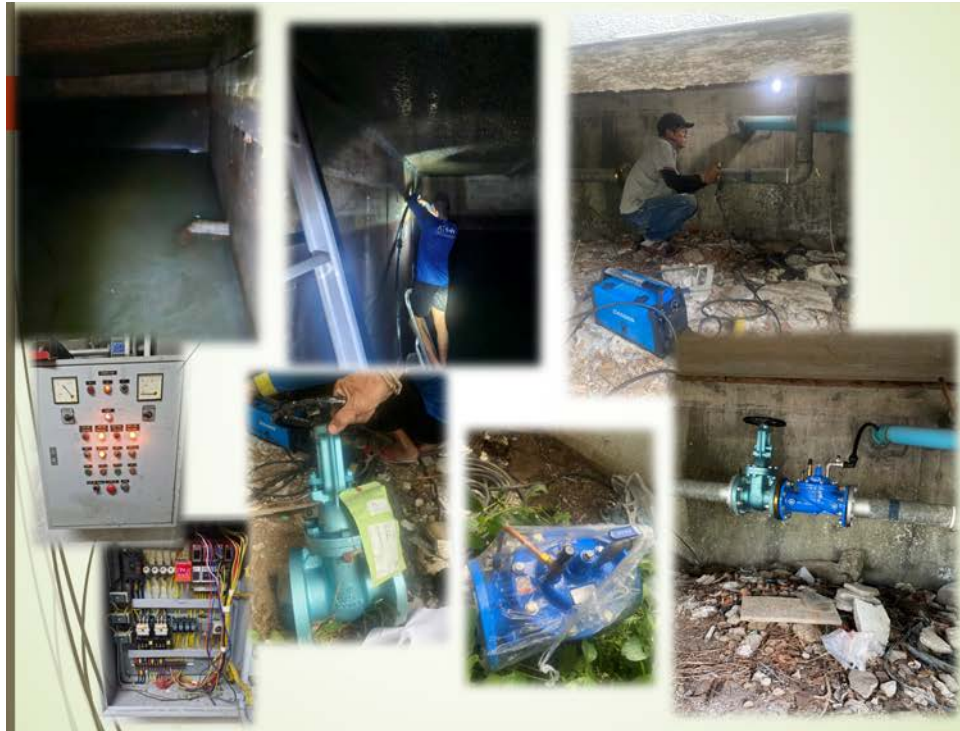
งานซ่อมแซมระบบควบคุมน้ำประปาเข้าแทงค์น้ำหลักของอาคาร 30 ปี (SCB1) คณะวิทยาศาสตร์
