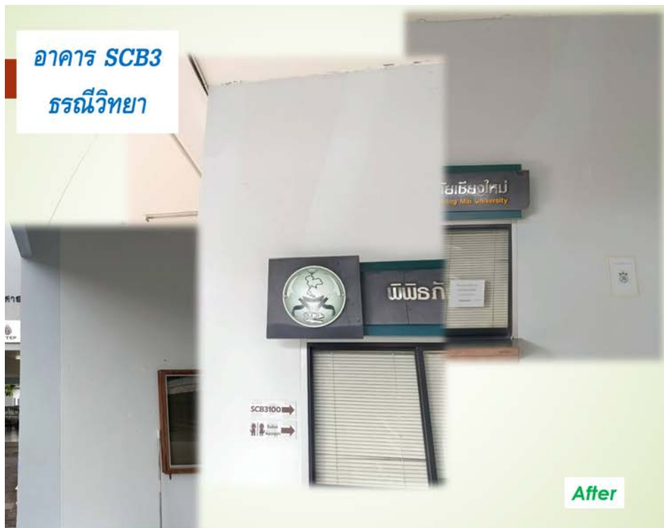
งานซ่อมแซมอาคารที่ได้รับผลกระทบจากเหตุการณ์แผ่นดินไหวเมื่อวันที่ 28 มีนาคม 2568
