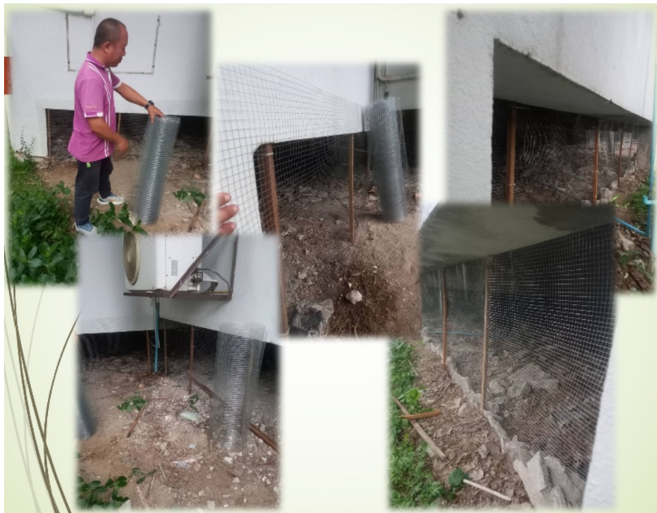
งานติดตั้งกรงตาข่ายป้องกันค้างคาวที่เข้ามาอาศัยชั้นใต้ถุนอาคาร 30 ปี (SCB1) คณะวิทยาศาสตร์
