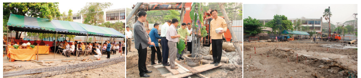
พิธีมงคลลงเสาเอก “อาคารเฉลิม ออยู่วิทยา” เมื่อวันที่ 16 มีนาคม 2558
